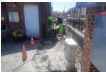
■ Travaux d'accessibilité aux bâtiments communaux (CCHF)
