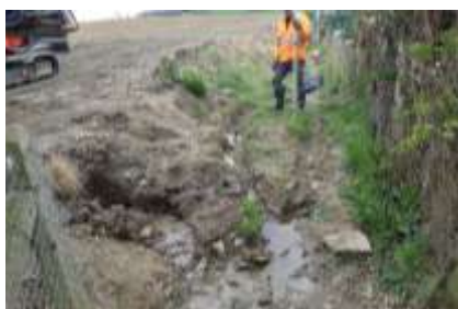
■ Creusement du fossé rue des Marguerites (Ville de Watten)
