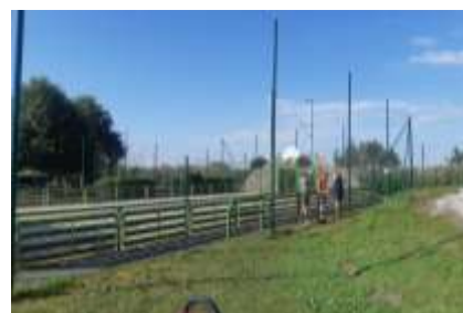
■ Réfection des filets du Parc des Tuileries (Sotrapac pour la Ville)
