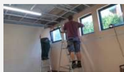
■ Réfection et peinture des vestiaires de la salle Besson (services techniques)
