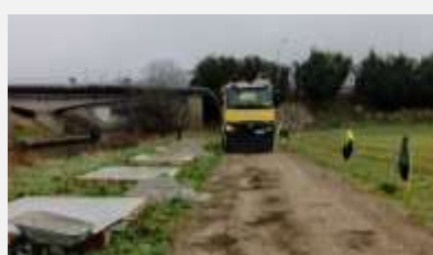
■ Travaux d'aménagement des jardins partagés (services techniques et entreprise)
