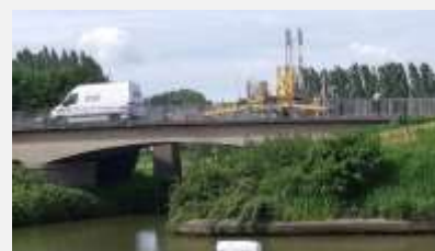
■ Diagnostic du pont de la rue Paul Mortier avec nacelle négative (CCHF)
