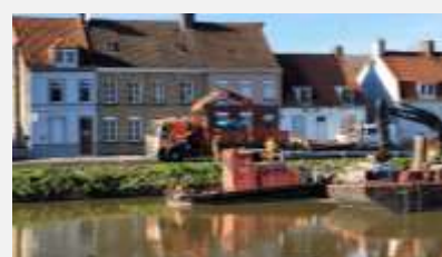
■ Pose de rambarde de sécurité le long du canal de l'Aa (Département du Nord)
