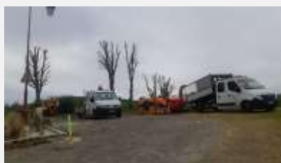
■ Elagage au parking du moulin (Sivom et services techniques)
