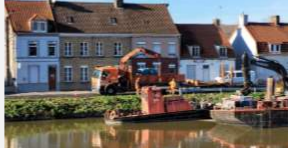
Fin des travaux de solidification des berges du canal
