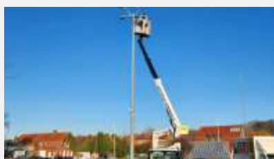
■ Passage à l'éclairage led à la ZA Vandesmet (CCHF)
