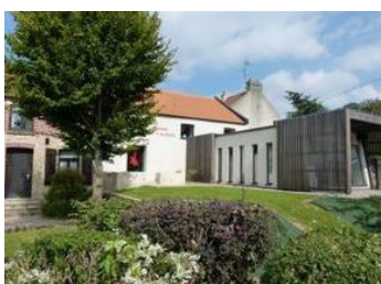
La façade extérieure de la Maison des Archers de Watten
